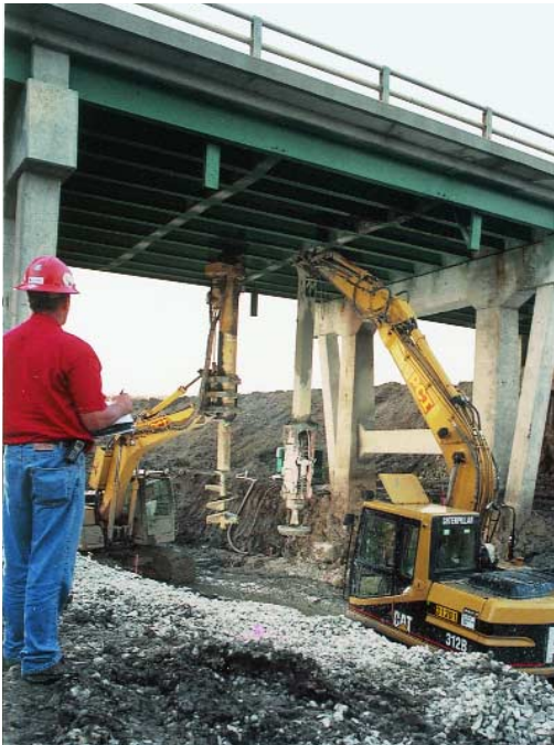
Box Culvert/soporte de terraplén en Neola, IA
