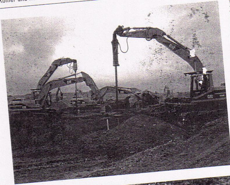
Bild 2. Für die Herstellung der Ramm-säulen verwendete Geräte.
