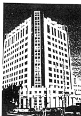
Bild 1 16-stöckiger Büroturm der von Aggregat-Pfählen gestützt wird
