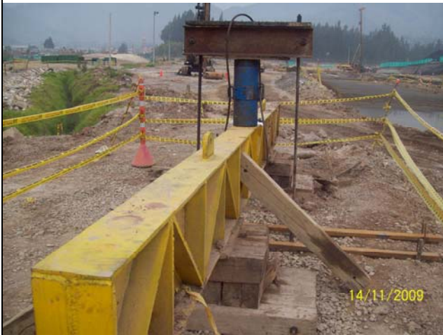
Figura 13. Ejecución de la prueba de tensión en una Pila de Agregado Compactado.
