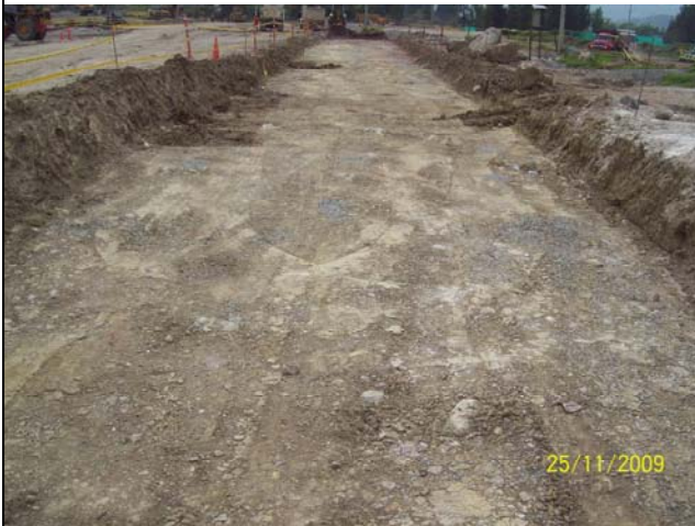
Figura 16. Elementos instalación y compactación superficial realizada.
