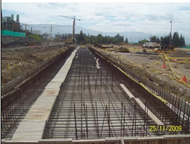
Figura 18. Instalación de acero de refuerzo.
