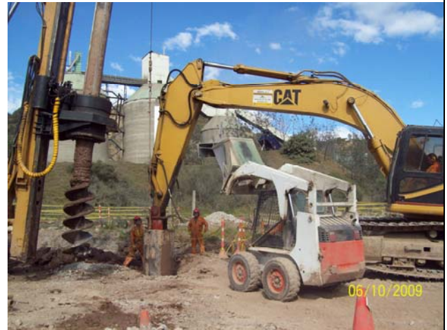
Figura 15. Instalación de Geopier® en el campo.
