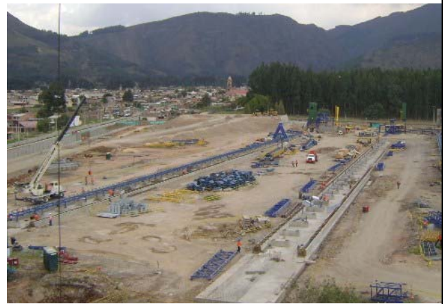
Figura 19. Construcción de Patio de Almacenamiento de Materias Primas soportado por Pilas de Agregado Compactado.
