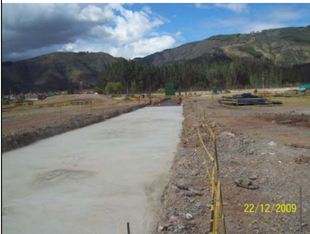
Figura 17. Instalación de mezcla de limpieza sobre los elementos.
