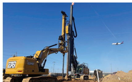
Geopier installation site
